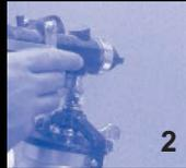
**Нанесение декоративного покрытия MULTICOLOR PIETRA, удерживая краскопульт в 25-30 см от стены перпендикулярно поверхности. Начинайте нанесение с горизонтальных полос, затем наносите материал по вертикали.**
