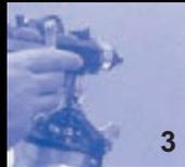
**Нанесение декоративного покрытия MULTICOLOR PIETRA, удерживая краскопульт в 45-50 см от стены перпендикулярно поверхности. Начинайте нанесение с горизонтальных полос, затем наносите материал по вертикали. Для получения высокого качества поверхности нанесите материал в диагональных направлениях.**
