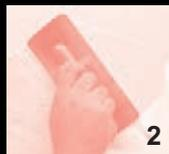
Нанесение первого слоя неколерованного декоративного покрытия Rustique тонким укрывающим слоем.
