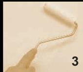
Нанесение второго слоя валиком с последующей обработкой поверхности пластиковым шпателем (шайбой) движениями «восьмерка», придающими фактуру. При подсыхании (примерно через 10 минут) еще раз приглаживать шпателем (шайбой).
