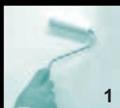
Нанесение грунтовочной краски Artigiano Basecoat в два слоя, заколерованной в цвет основного покрытия.
