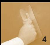
Заглаживание нанесенного декоративного покрытия плоской стороной шпателя.
