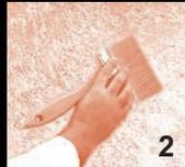
Нанесение декоративного покрытия малярной плоской кистью хаотичными перекрестными движениями.
