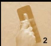
Нанесение первого слоя декоративного покрытия шпателем дугообразными движениями тонким ровным слоем, как шпатлевку, избегая стыков.
