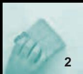
Нанесение кистью декоративного покрытия MULTICOLOR PERLA хаотичными мазками в произвольных направлениях.
