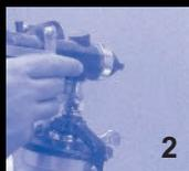
Нанесение декоративного покрытия MULTICOLOR PERLA, удерживая краскопульт в 25-30 см от стены перпендикулярно поверхности. Начинайте нанесение с горизонтальных полос, затем наносите материал по вертикали.
