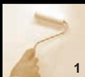
**Нанесение:** основание должно быть чистым, сухим, твёрдым и прочным. Сильно впитывающие основания загрунтовать грунтовкой глубокого проникновения.
