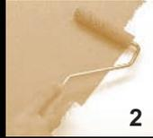
Нанесение первого слоя декоративного покрытия, разбавленного на 30% водой, валиком.
