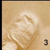
Нанесение специальной рукавицей круговыми движениями колерованного воскового покрытия Cera.
