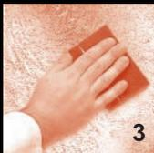
Приглаживание пластиковым шпателем микрокапсул в хаотичном порядке или в одном направлении (например, в диагональном) в зависимости от желаемого рисунка.
