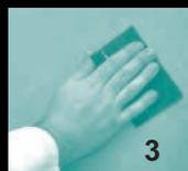
Приглаживание шпателем микрокапсул в хаотичном порядке или в одном направлении (например, в диагональном).
