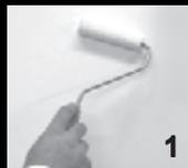
Нанесение грунтовочной краски Artigiano Basecoat, заколерованной в цвет основного покрытия, валиком в два слоя.
