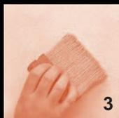
Растушевка поверхности кистью плавными, разметающими разнонаправленными движениями.
