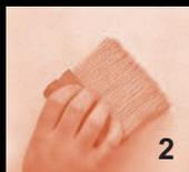
Нанесение декоративного покрытия кистью разнонаправленными перекрестными движениями.
