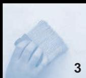
Растушевка поверхности кистью. Водите кистью вертикальными (диагональными) движениями по поверхности нанесенного ранее материала.
