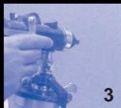
Нанесение декоративного покрытия MULTICOLOR PERLA, удерживая краскопульт в 45-50 см от стены перпендикулярно поверхности. Начинайте нанесение с горизонтальных полос, затем наносите материал по вертикали. Для получения высокого качества поверхности нанесите материал в диагональных направлениях.
